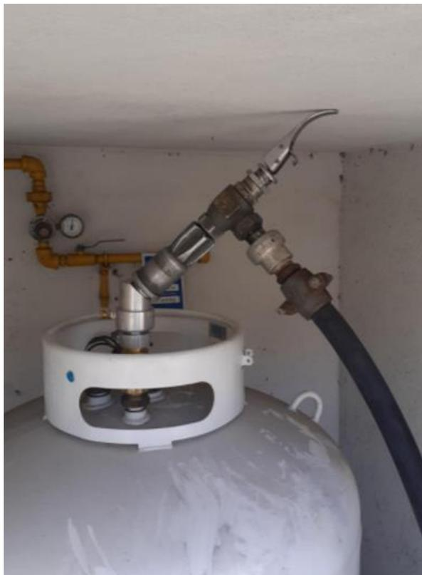
Após testar o protótipo e verificado que seu uso é satisfatório para essa operação, foi fabricada a válvula adaptadora em ângulo definitiva, construída em latão.
