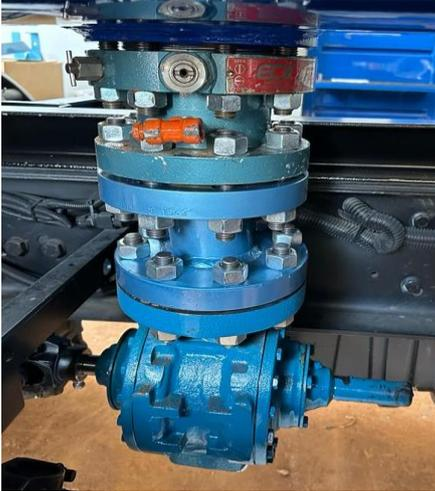
Bomba de 3", instalada após o carretel da válvula de fundo (Esquema hidráulico atual, impossibilitando a instalação de uma válvula automatizada de redundância da válvula de fundo).
