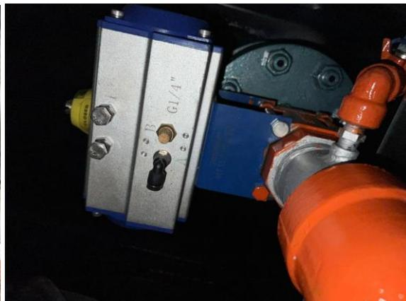
Foto vista por baixo, ilustrando a válvula automatizada de redundância instalada logo abaixo da válvula de fundo
