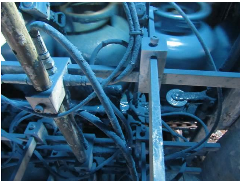
Figura 5 - Overspray na cabine de pintura
