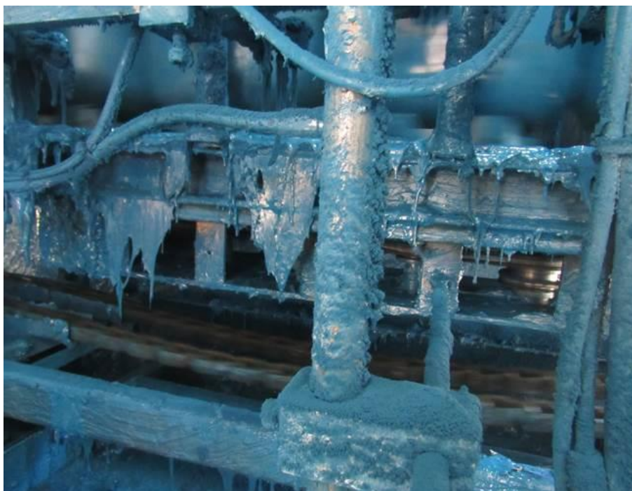
Figura 6 - Cabine de pintura ao final do período de teste.
