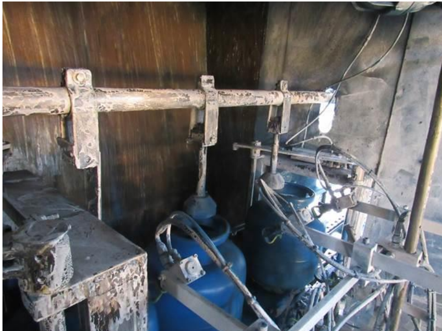
Figura 7 - Cabine após aplicação de água e remoção do gel.
