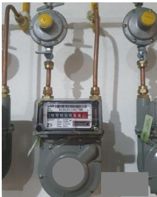
FIGURA 2 – REPRESENTAÇÃO REAL COM REGULADORES COM MANIPULO PARA FECHAMENTO E ABERTURA RESPECTIVAMENTE
